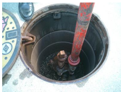
② スタントパイプを接続する
